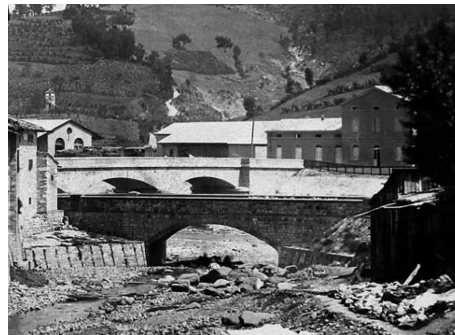
Il ponte della Porrettana sul torrente Rio Maggiore nel centro abitato di Porretta negli anni Sessanta dell'Ottocento. In secondo piano il ponte che conduce alla nuova stazione ferroviaria.
