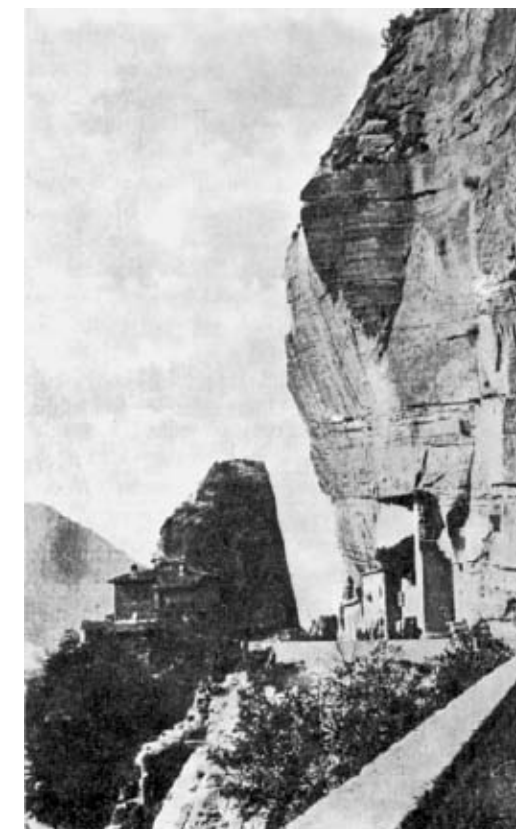
La rupe del Sasso negli anni Sessanta dell'Ottocento. Il taglio, cominciato nel 1816, aveva consentito il passaggio della nuova strada. Si notano le sporgenze di roccia che avrebbero provocato il crollo del 1892.
