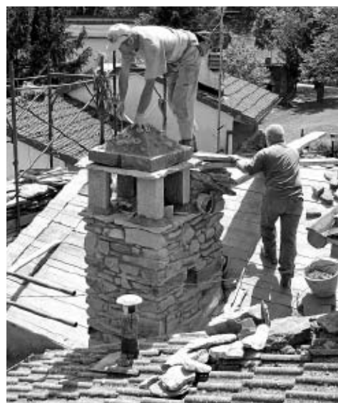
Sono tornati i maestri lombardi, costruzione di un particolare comignolo in pietra arenaria.
