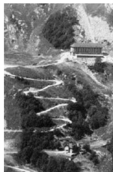
Fig. 37. La Valle delle Pozze, veduta panoramica nel grande albergo a quota 1700 e di una delle ville fino a quel momento realizzate.
