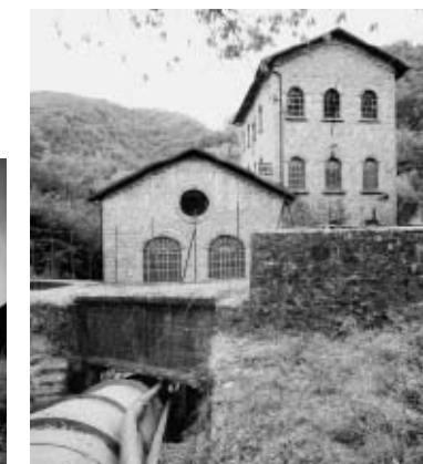
Fig. 16. Centrale idroelettrica della Lima, Fabbriche di Bagni di Lucca (Lucca), Angelo Omodeo, 1910.
