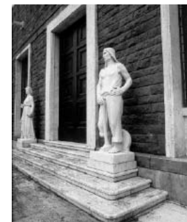
Fig. 10. Centrale idroelettrica di Pian della Rocca, Borgo a Mozzano (Lucca), Alfonso Gervaso, 1939-41.
