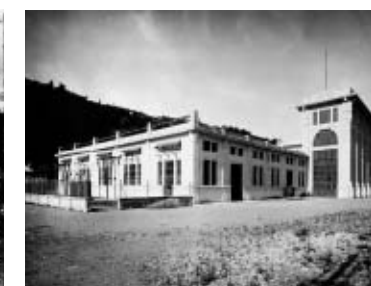
Fig. 15. Centrale idroelettrica di Farneta, Montefiorino (Modena), 1924-28.
