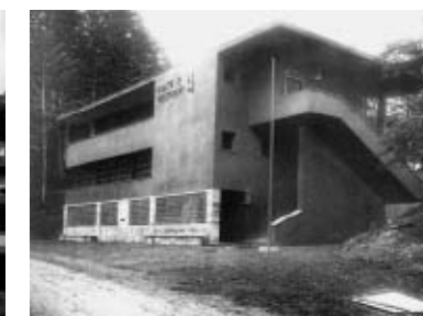
Fig. 2. Palazzo delle Poste e Telecomunicazioni di Abetone (Pistoia), Angiolo Mazzoni, 1936.
