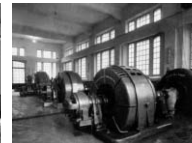
Fig. 31. Centrale Idroelettrica di Sperando, San Marcello Pistoiese-La Lima, (Pistoia), Lapo Farinati Degli Uberti, 1913. Veduta della sala macchine.
