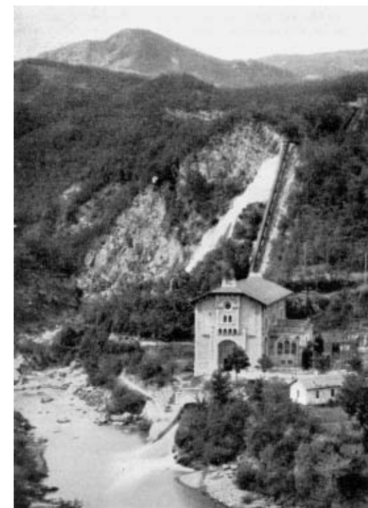
Fig. 22. Centrale idroelettrica di Strettara, Montecreto, Lama Mocogno (Modena), Gaetano Ganassini con Attilio Racheli, 1917-20
