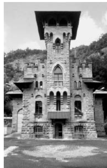
Fig. 27. Centrale Idroelettrica di San Michele al Sagradino, Pievepelago (Modena), Lapo Farinati Degli Uberti, 1919-20.
