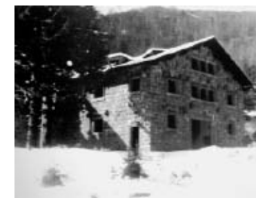
Fig. 39. La Valle delle Pozze, autorimessa.
