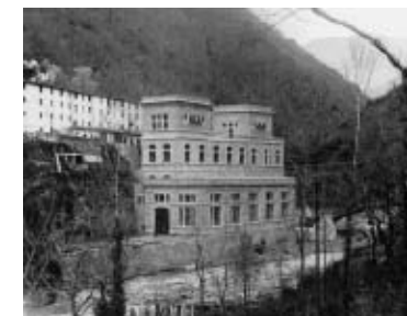
Fig. 28. Centrale Idroelettrica di Sperando, San Marcello Pistoiese-La Lima, (Pistoia), Lapo Farinati Degli Uberti, 1913.
