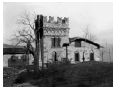
Fig. 17. Ville in località Poggioraso, Sestola (Modena), Perfetti, 1927.
