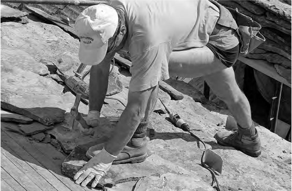
Allettamento delle lastre di arenaria sul piano di falda.
