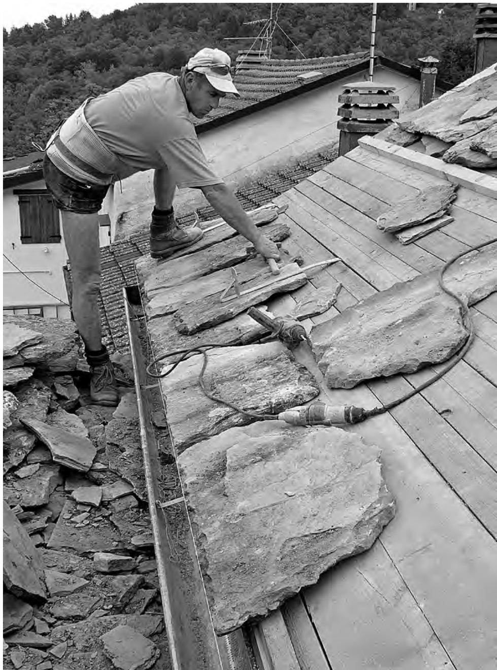
Tecnica di posa delle lastre di arenaria di testa in gronda.
