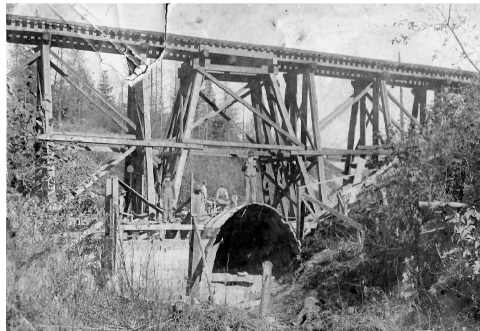
Costruzione dei ponti sulla Transcanadiana.
