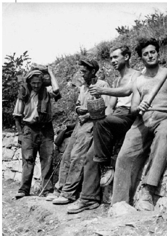
Operai al cantiere "Fanfani".
